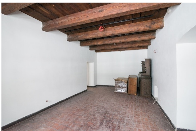
(widok od wejścia z sali 01 w kierunku wejścia z sali 03)
