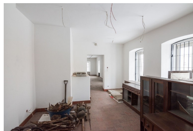
widok w kierunku przejścia z sali 04
